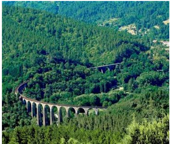
Viaduc de Chamborigaud
